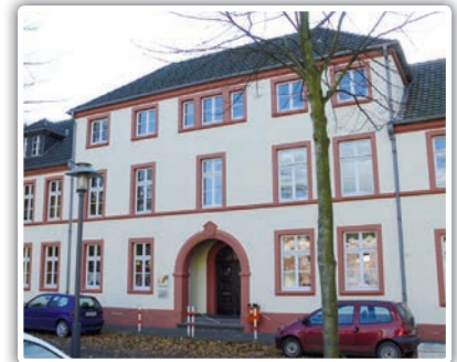
Ev. Familienzentrum Regenbogenhaus
